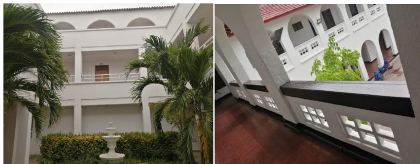
Ilustración 16. Interiores Sedes Administrativa y Académica. Fuente: Informes de obra
