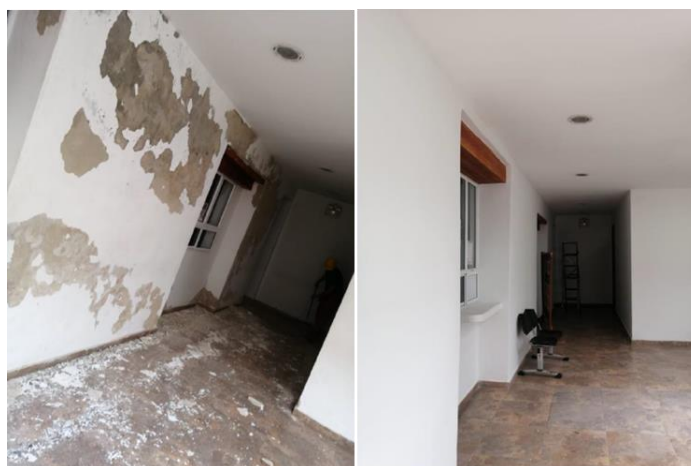
Ilustración 15. Interior sede Administrativa INFOTEP. Fuente: Informes de obra
