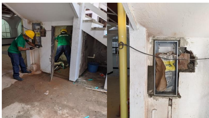
Ilustración 17. Adecuaciones tableros eléctricos. Fuente: Informes de obra
